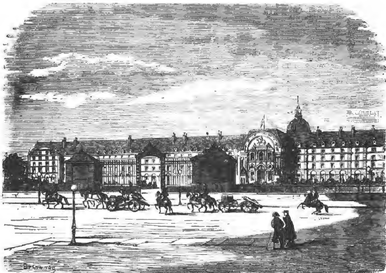
La façade des Invalides
