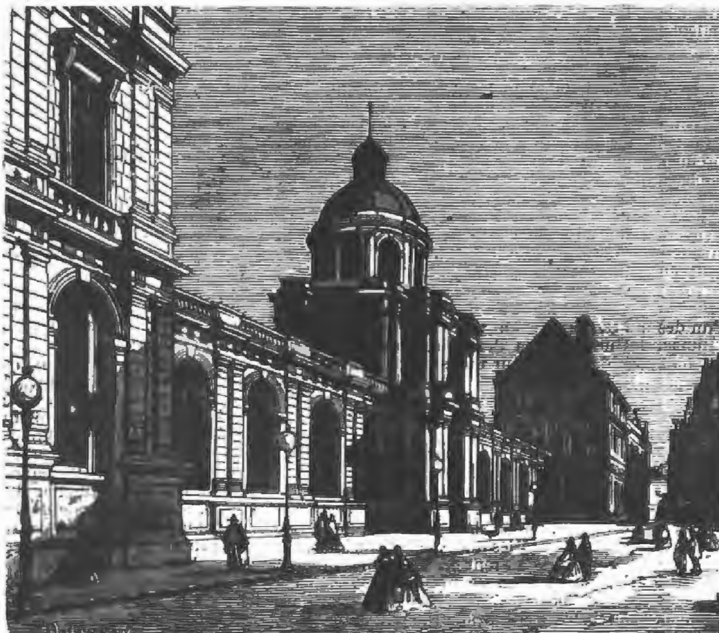
La façade du palais du Luxembourg, rue de Vaugirard.
